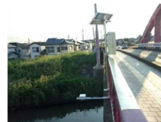
【電波式水位計設置例】
