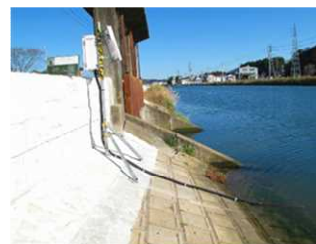
【圧力式水位計設置例】
