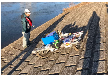
写真 1 護岸探査状況
