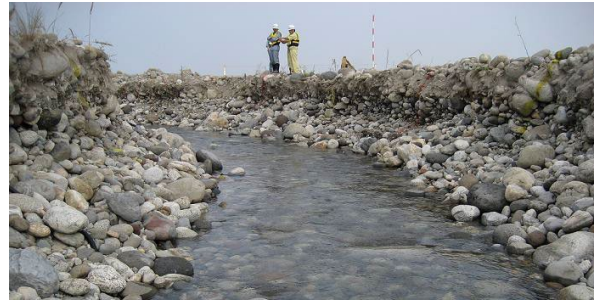
図-1 2006年常願寺川現地実験の通水後の河岸
