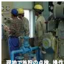
現地で施設の点検、操作
