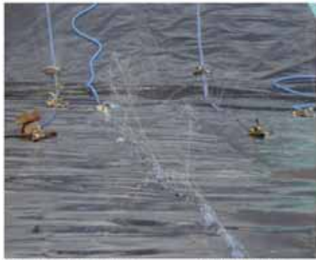
図-26 透気遮水シート敷設状況
