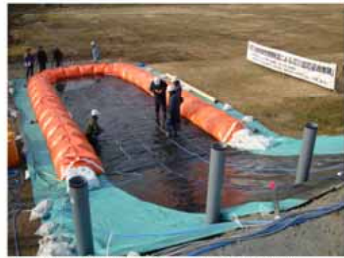
図-27 透気遮水シート敷設状況
