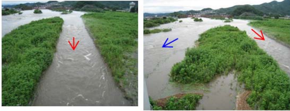
図 17 小規模掘削路による砂州への洪水誘導
