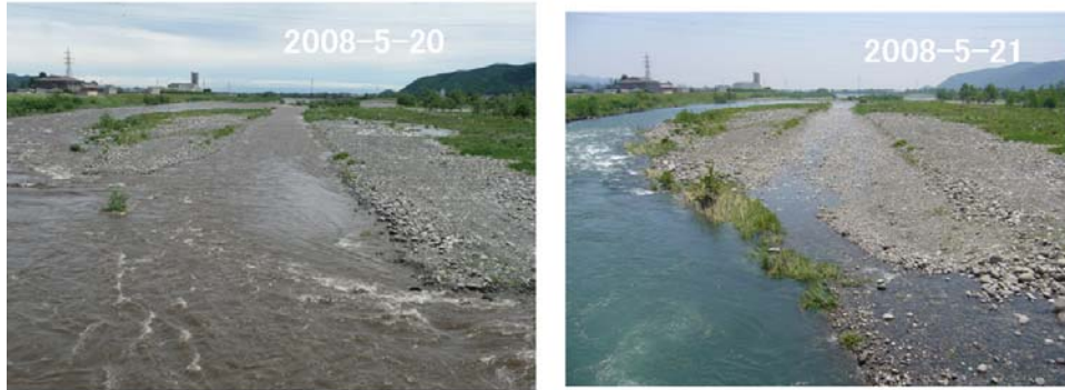
図 28 昭和橋下流右岸砂州における掘削路への流入状況と流入後の様子
