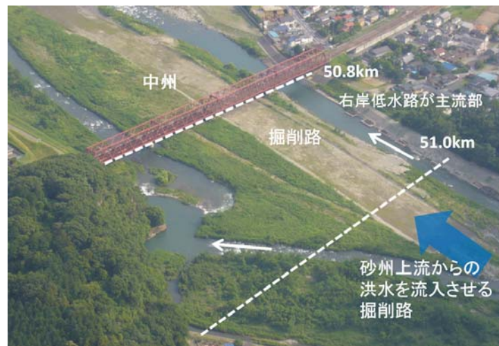
図 5 中州に掘削路を設けた状況
