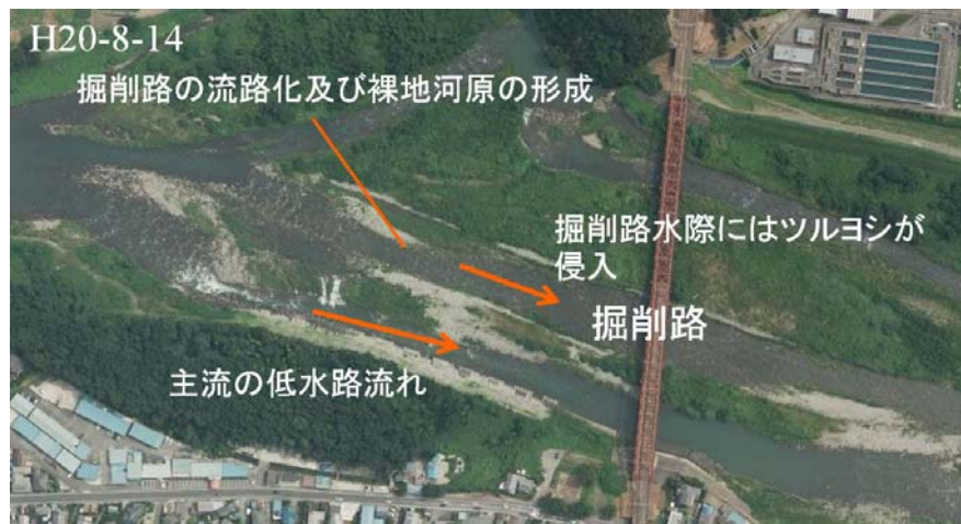
図 9 1年経過後の中州の状況
