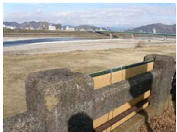
長良川の特特殊堤（洪水時に畳を挿入する）
