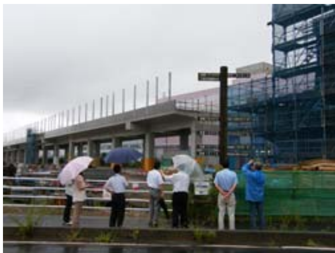
洪水水位標の全景
