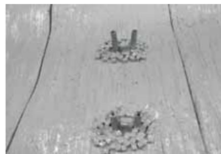
図-15 橋脚モデルに使用したゴム素材の根固め
