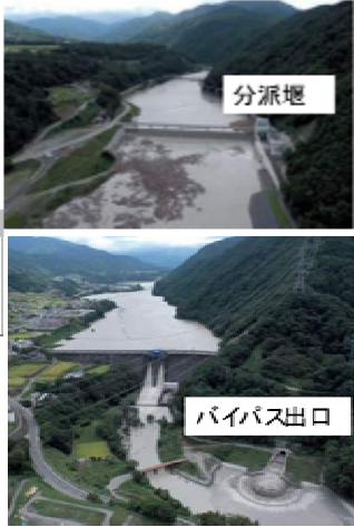
図 1 美和ダム排砂バイパストンネル概要とバイパス放流操作の例 (H19.9 洪水)
