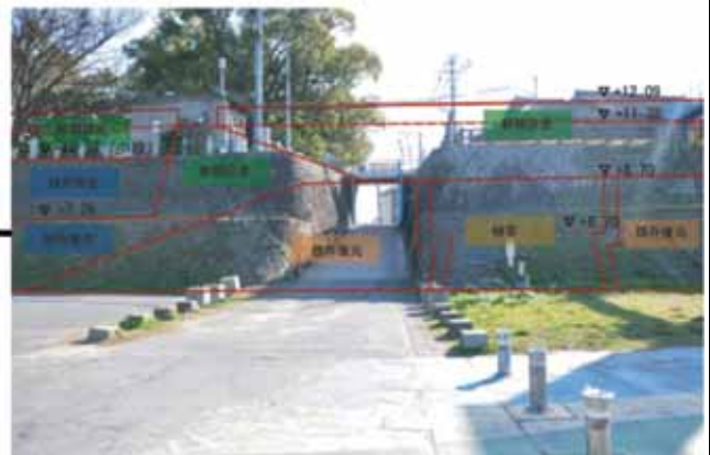
①石積みおよび陸間の工事前の状況
