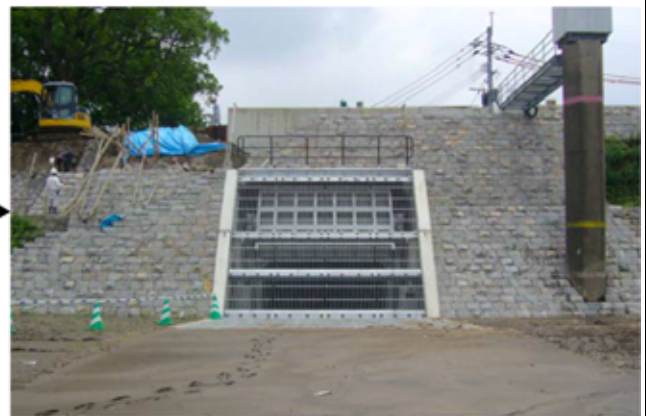
④石積みの復元・新築が完了
