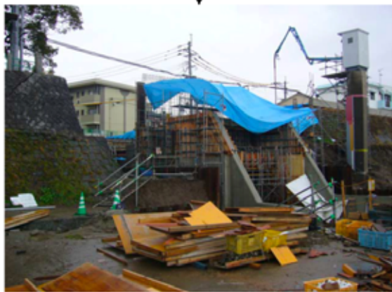
③樋門の設置工事
