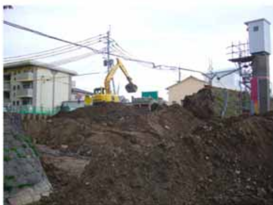
②石積みの撤去
