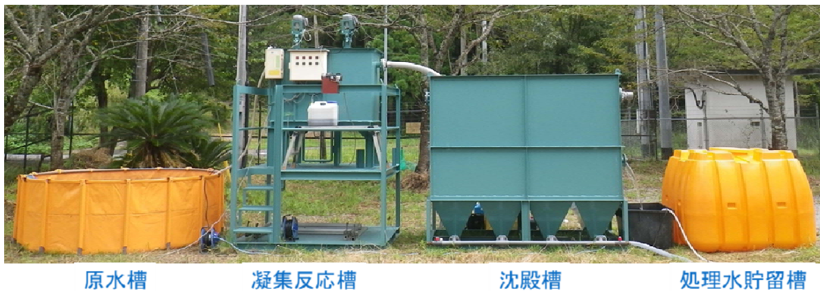
図 5 改修した濁水処理プラントの構築状況
