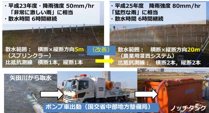
図-4 実堤防散水試験の様子
