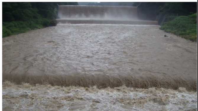
図-4 本宮堰堤下流 (第 3 副堤直上流) における流況 (2025 年 8 月 7 日 9:05)
