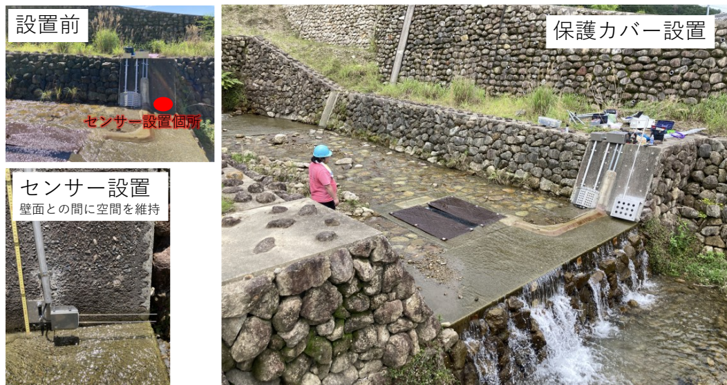
図4 内の川における TDR センサー設置の様子
