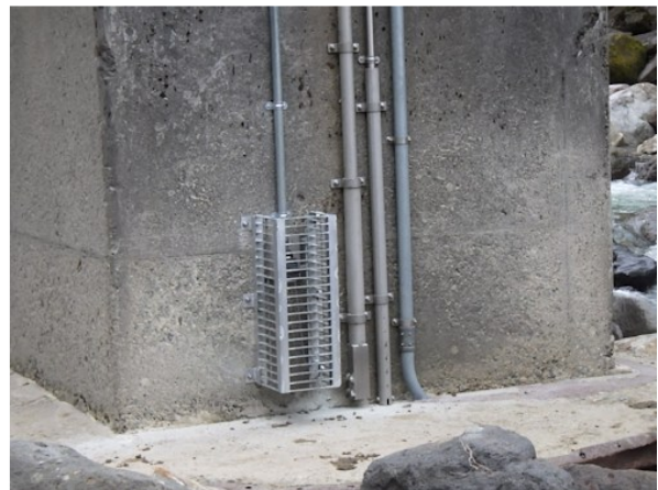
図6 常願寺川妙寿砂防堰堤下流の橋脚（上）に設置したTDRセンサー（下）。TDRセンサーは保護用金属格子の内部に設置した。
