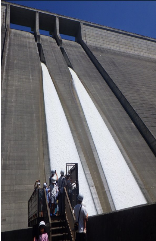
ダム下流広場の状況
