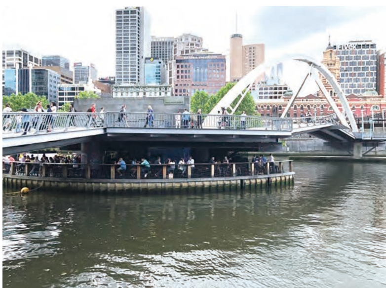
橋脚部のバー(オーストラリア:ヤラ川)
