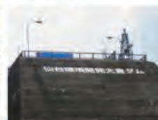
ダム堤体看板
