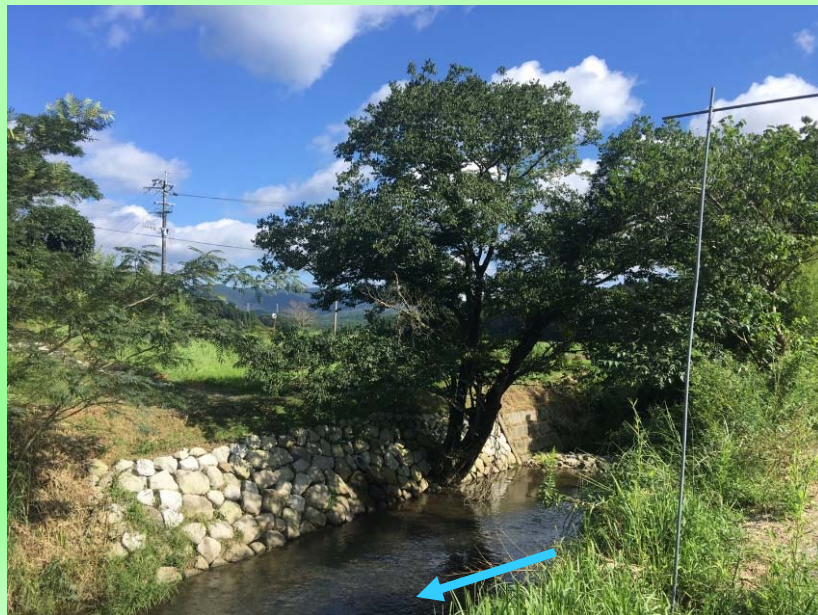
施工後5カ月 (H29.9.28)
