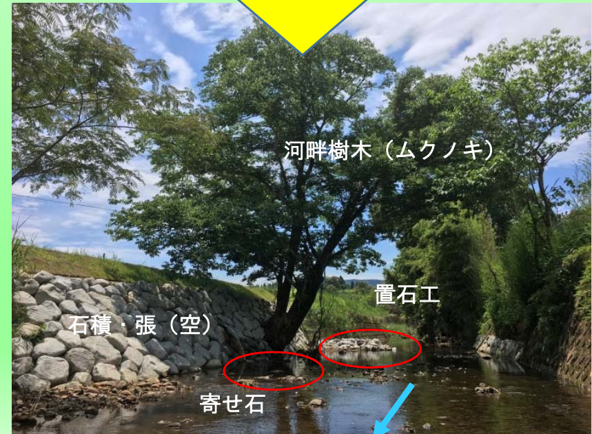
施工後1カ月 (H29.6.5)
