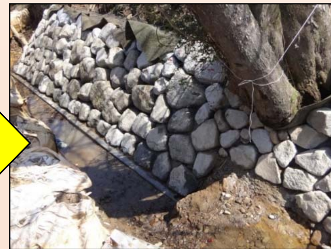
埋め戻し前 完了
