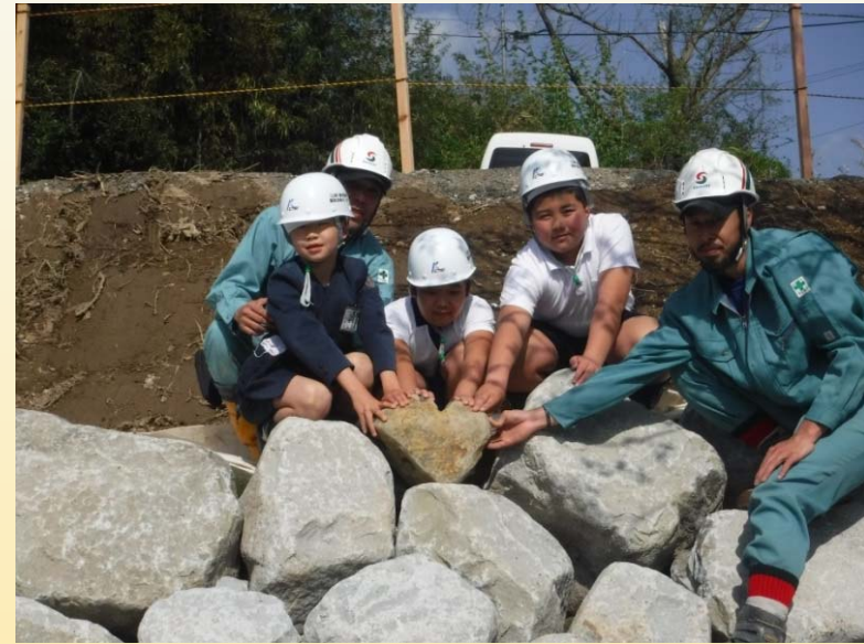
ハート石の据付け作業
