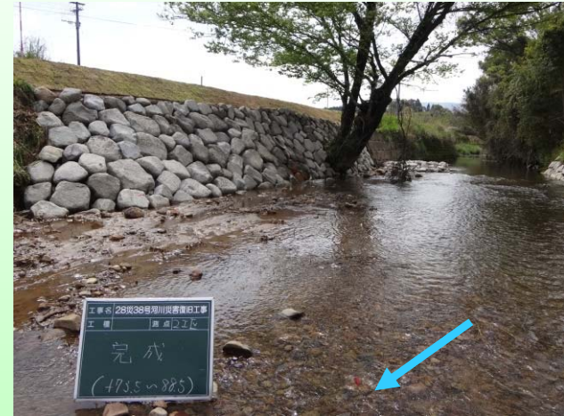
施工直後 (H29.4.27)
