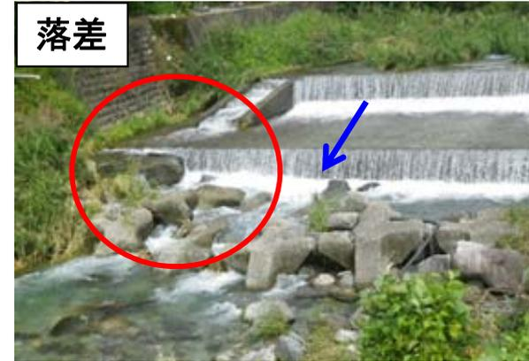
・洗掘により魚道下流に落差が生じ、遡上が困難に陥った事例
