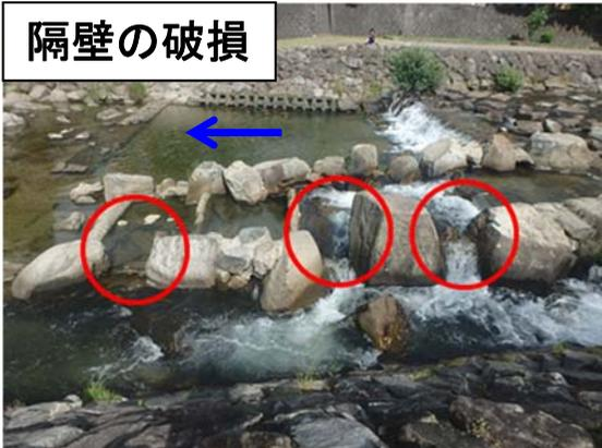
・隔壁が破損し、魚道内の水深が確保されないなどの問題を抱えている事例
