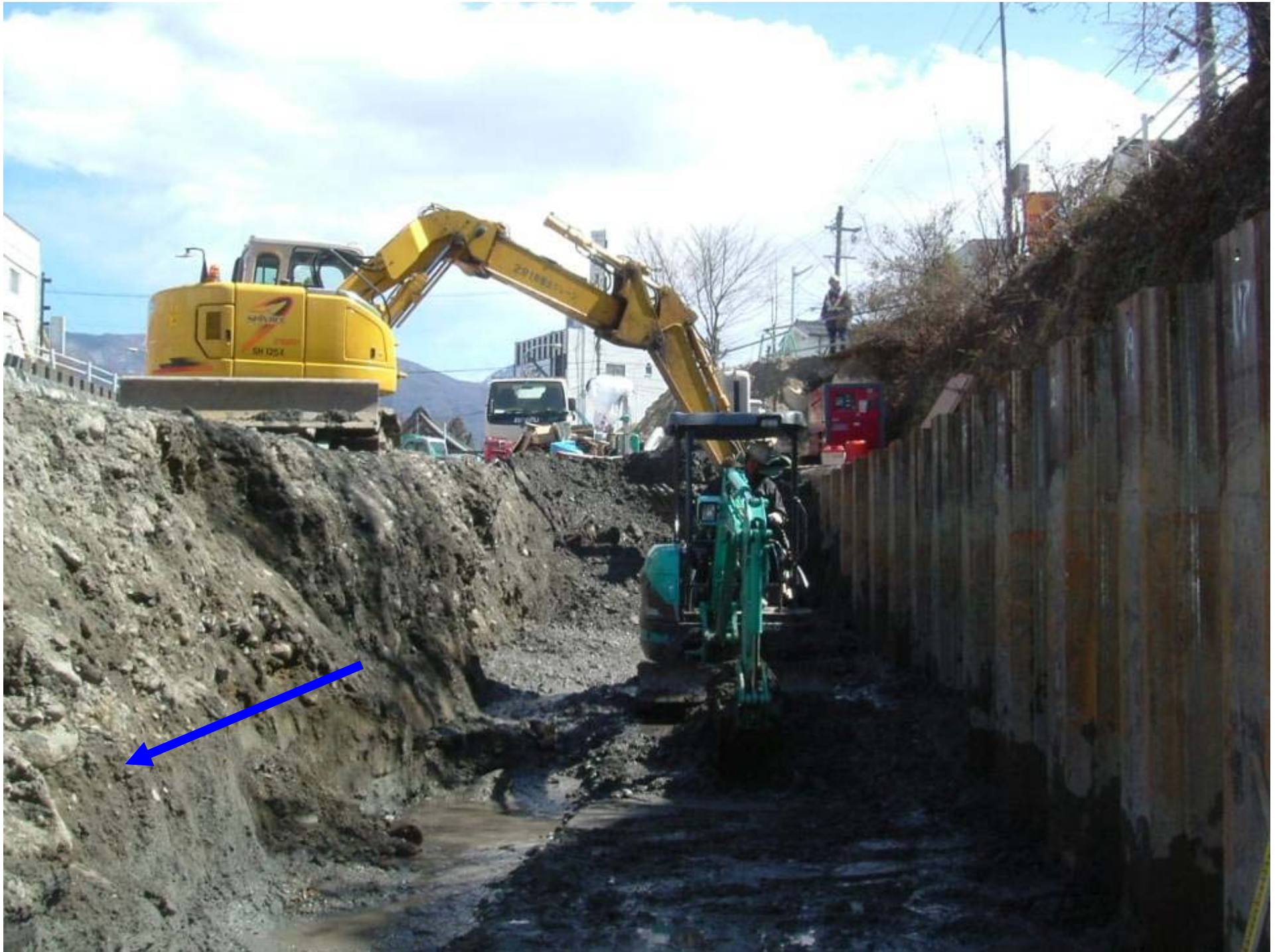
止水完了後矢板前面掘削
