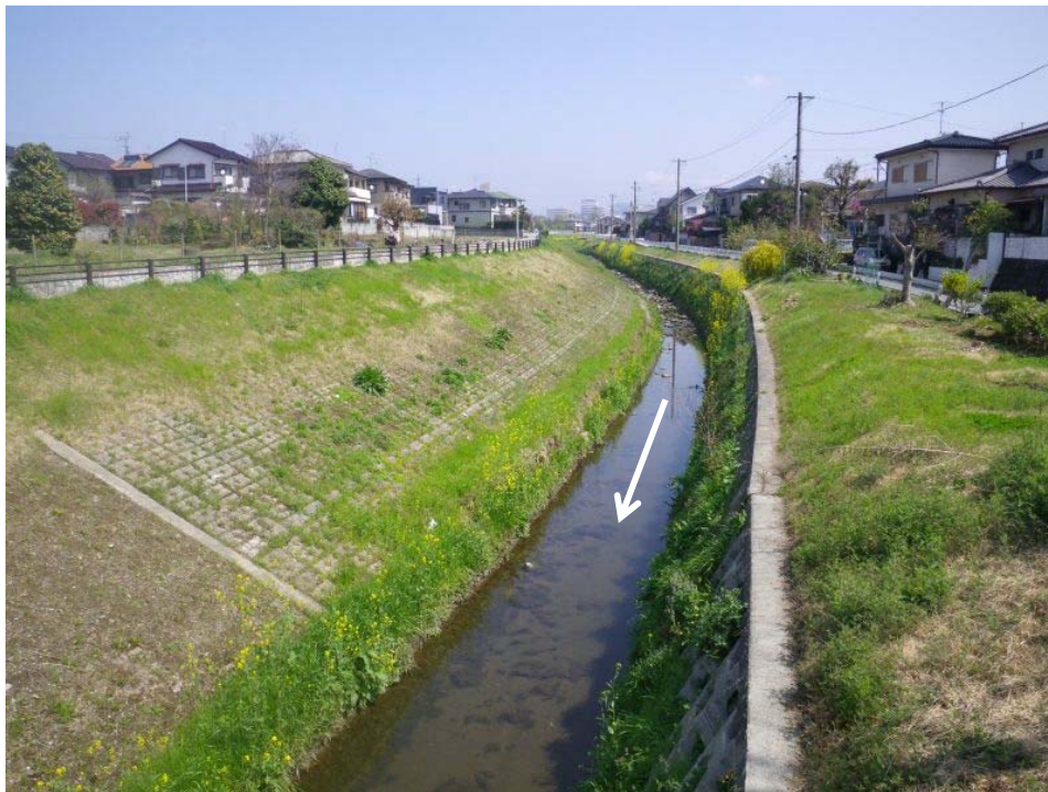
施工2年後(平成25年3月)
