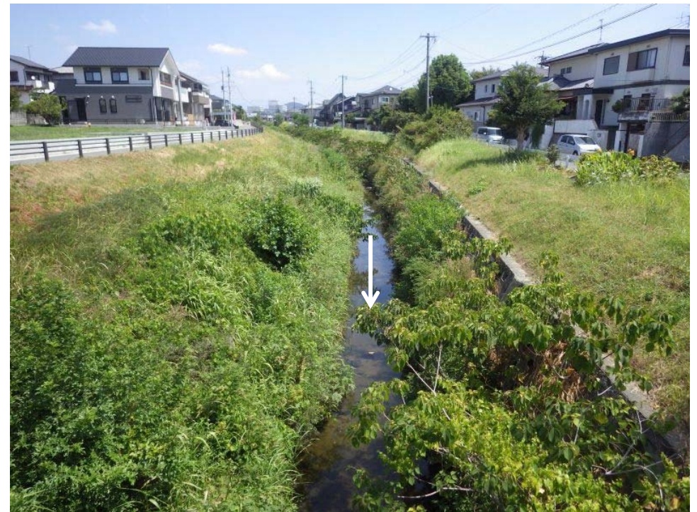
施工8年後(平成30年7月)
