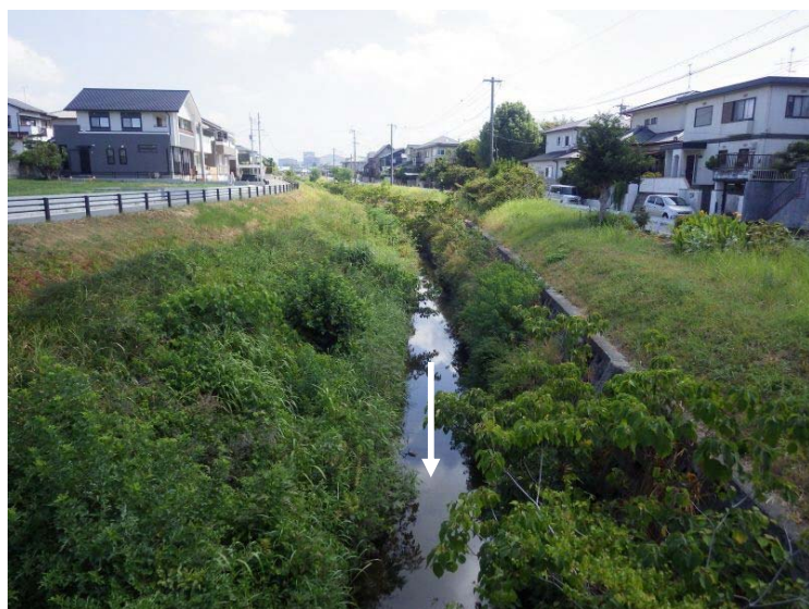
下流域(多自然川づくり整備済)
