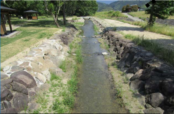
改良水路(既存木橋上流)
