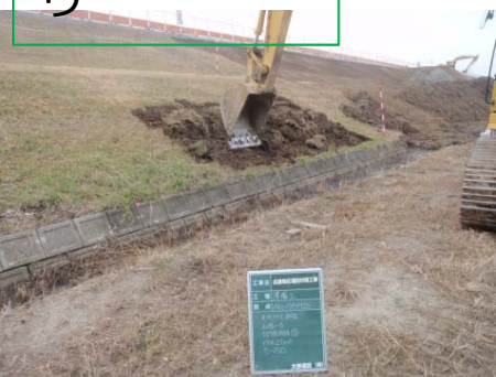
移植元表土の掘り取り
