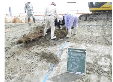
施工後法面への植え戻し
