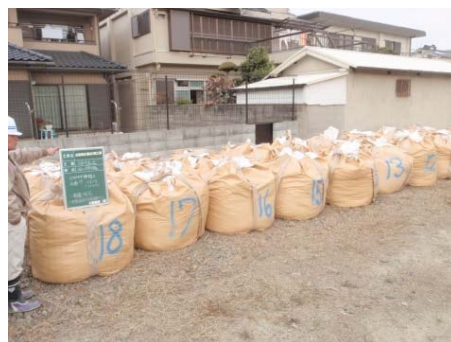
袋詰めされた表土
