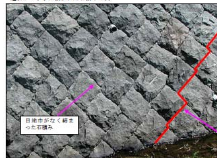
適切かつ丁寧に積まれた石積みの例
