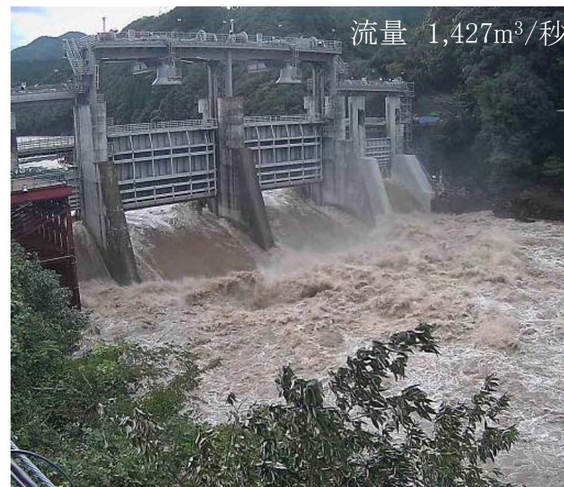
西郷ダムでの通砂状況
