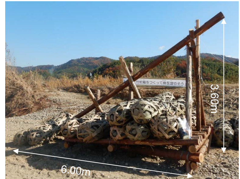
図-木津川に設置した中聖牛
