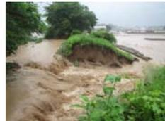
写真-1 金鏡工区 破堤状況
