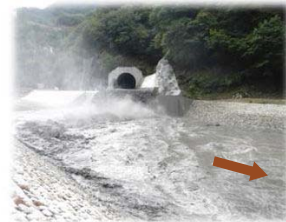
土砂バイパス吐口 放流状況
