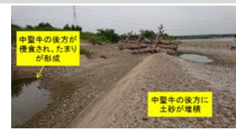
聖牛工 構造
