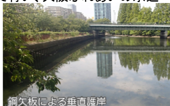
鋼欠板による垂直護岸
