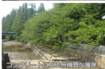
コンクリートによる無機質な護岸
