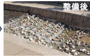
水辺の小わざ魚道・・・天然石を並べ、小さなプールを連続的に設ける
