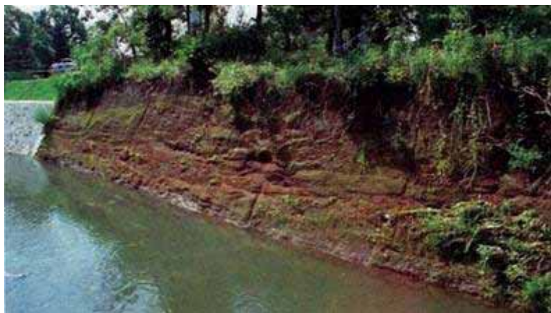
護岸を設置せずに土羽のまま放置した例（神奈川県境川） 左は施工直後、右は3年後の状況
