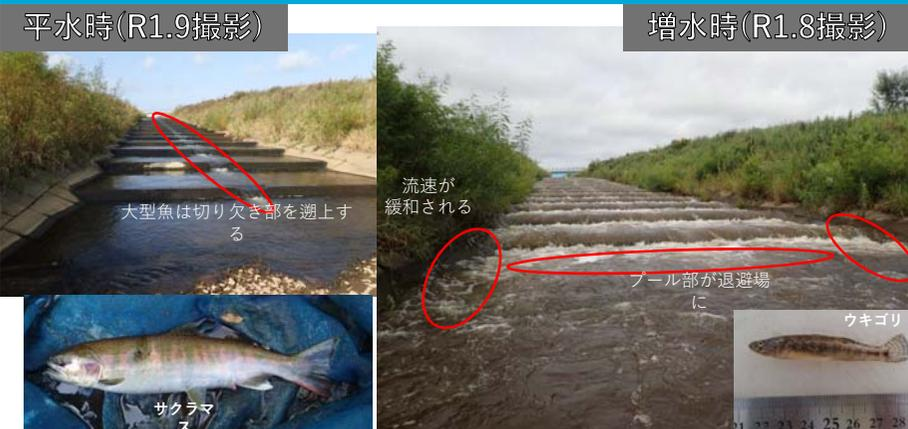
・魚道各段の中央部に切り欠きを設け、落差を低段とすることで、平水時でも大型の魚種(サクラマス、サケなど)が容易に遡上できる経路を確保した
