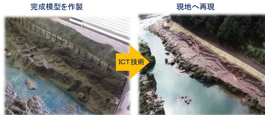
完成模型により、岩盤の掘削形状が見える化することで課題解決を図れるのではないかと発想
