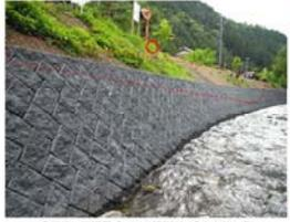
○天端に天端用ブロックが割り付けられた施工例
