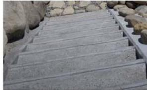
洗出し仕上げでの階段施工例(中川原地区)
