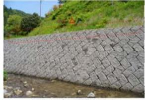
△天端にカットブロックが配置された施工例
