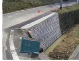
×天端にコンクリートで調整された施工例
