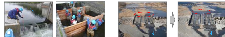
H27調布取水堰：点検状況(左)、魚道の補修状況(右) H28羽村第三床固：魚道上流の堆積土砂を撤去し、遡上後の迷入を防止
