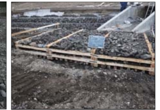
吐出口部の木工沈床工
