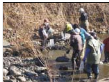
工事前の水生生物救出作業 ○市民団体・東京都・受注者・世田谷区
