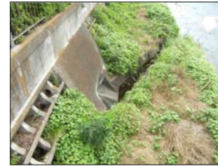
国分寺崖線からの湧水水路（施工前）
