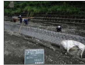
自然石（低水）護岸工
