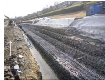
かごマット敷設状況
