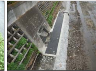
国分寺崖線からの湧水水路（施工後）
