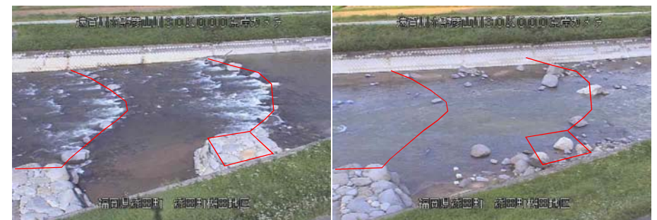
上流水制・分散型落差工流出
