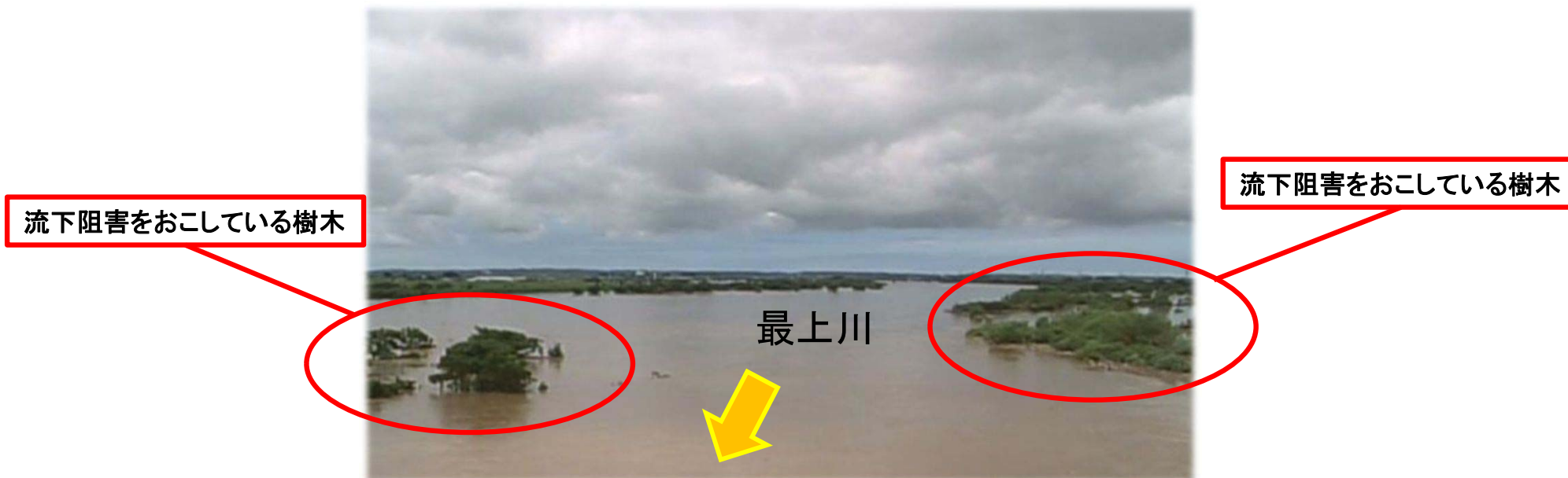
▲H30.8月出水の様子(12.0k付近)
