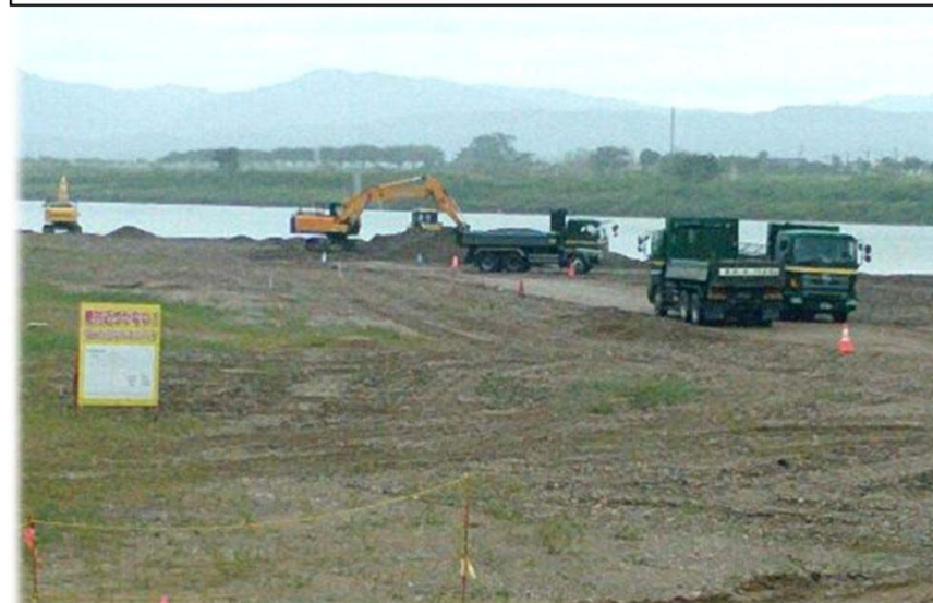
▲河道掘削状況
