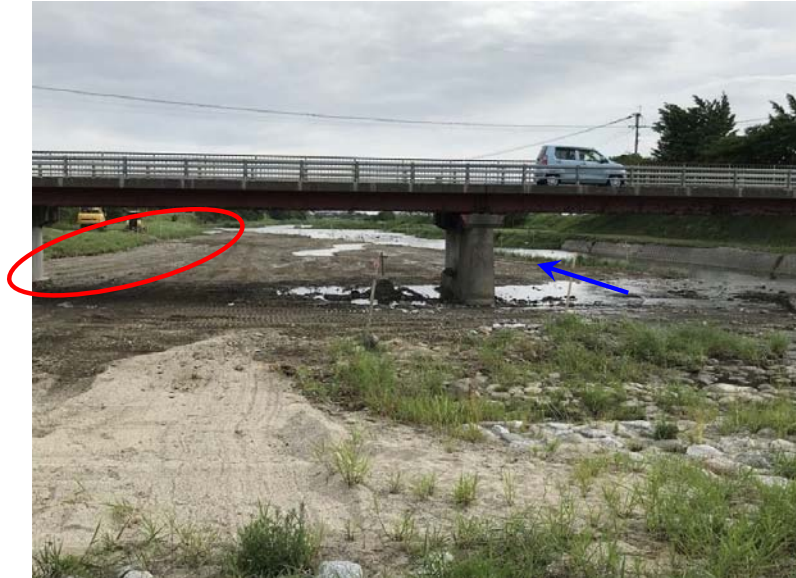
浚渫完了直後(R1.5)
