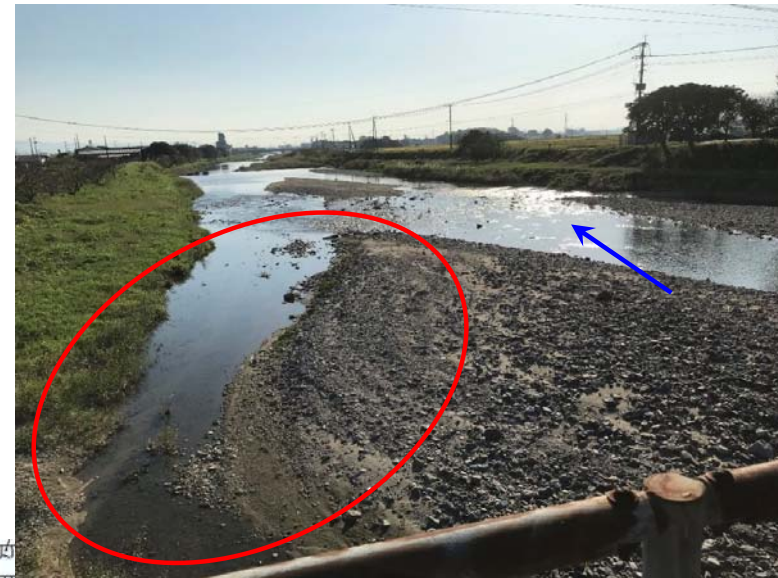
浚渫完了5ヶ月後(R1.10)
