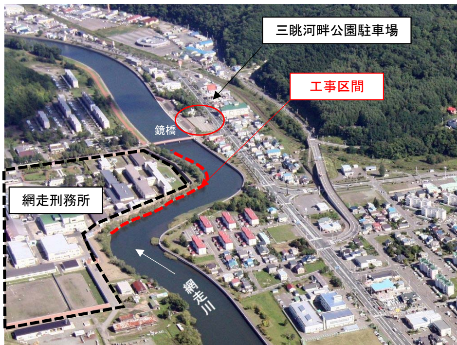
工事箇所周辺の様子(平成19年撮影)
