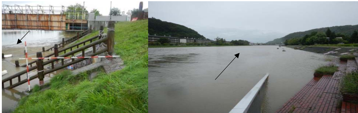
平成28年8月洪水時の状況 KP4.0鏡橋下流付近
