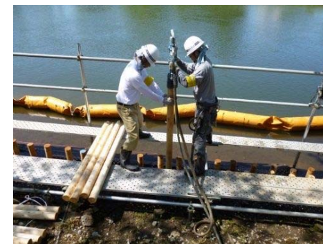
木杭工施工状況
