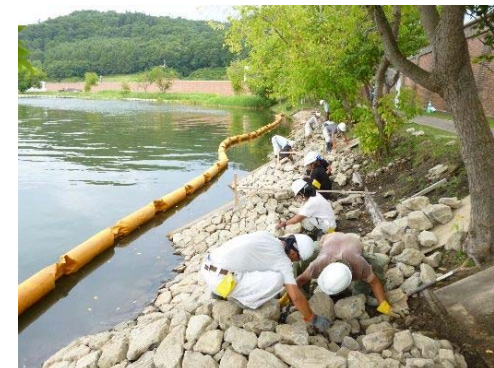
石張工施工状況
