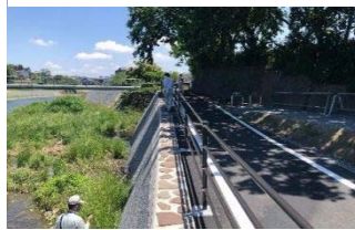
景観に配慮した防護柵
