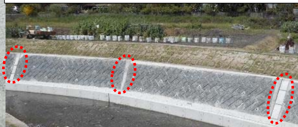
他現場の目地コンクリート 施工状況
