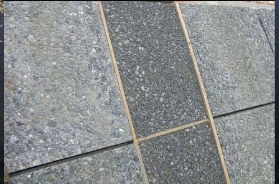
護岸の素材感と類似するような施工工夫
