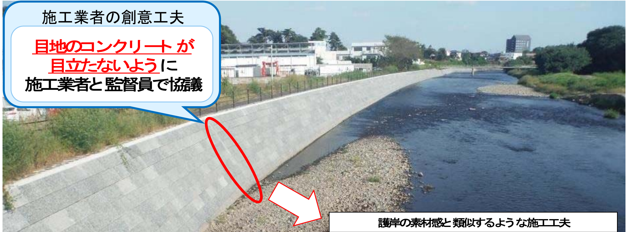
他現場の目地コンクリート 施工状況
