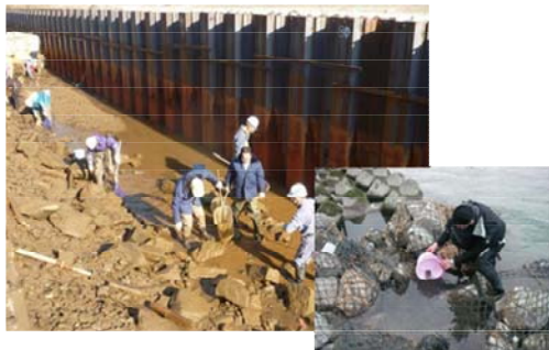
救出作業状況
