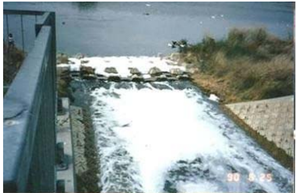
流入支川から汚濁水の流入
