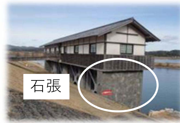
実崎樋門（右岸3k+100m）
