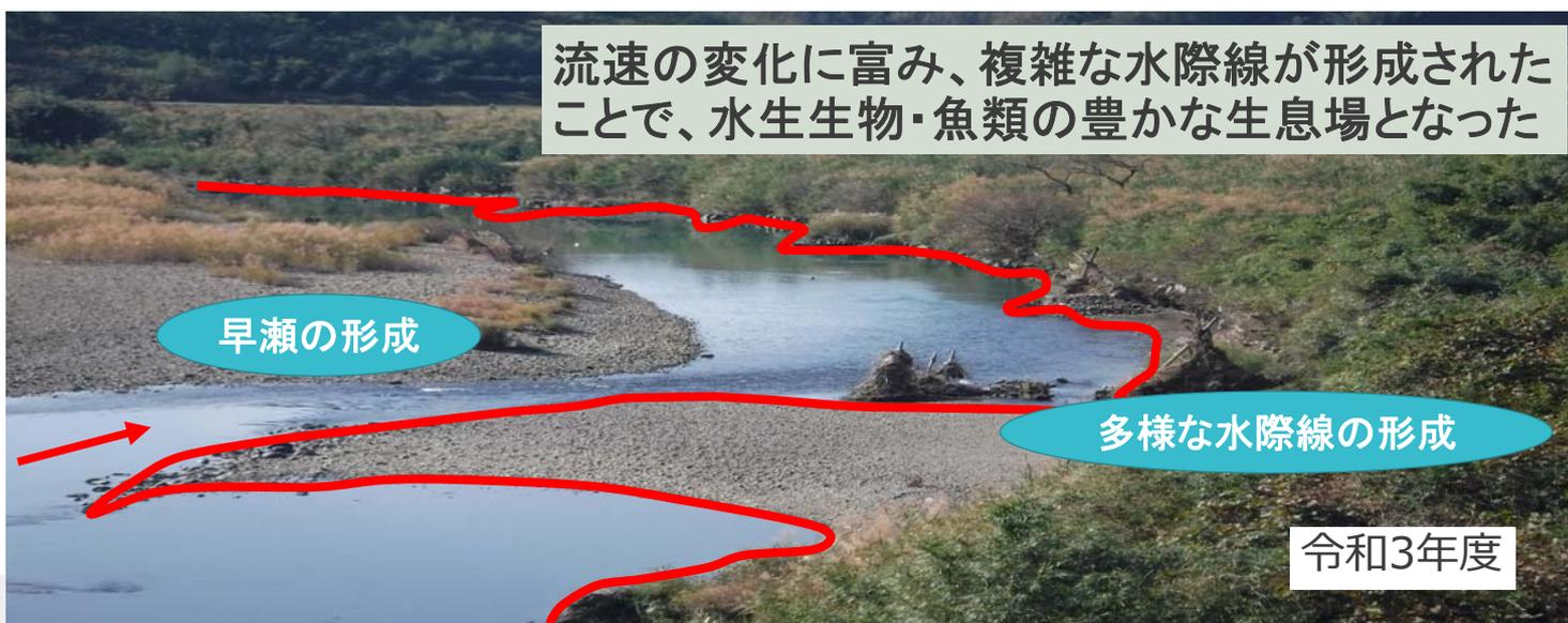
本現場は水衝部に伝統工法の大聖牛（水制工）を設置し、護岸を保護するとともに、土砂堆積により瀬や淵が形成され、自然豊かな水辺を創出した事例である。設置より19年経過後の土砂堆積モニタリングでは、大聖牛の上部が流出しているものでも、残存した基礎部により堆砂促進が図られることを確認できた。
