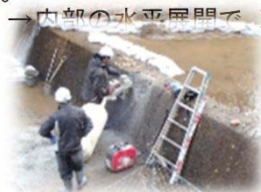
施工状況(R1.11)
