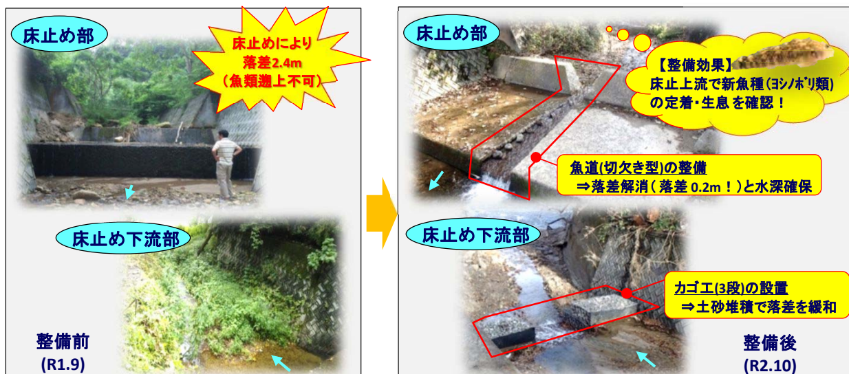
魚道整備の状況と整備効果(左：整備前、右：整備後)
