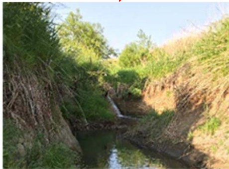
行人樋管排水路の荒川流入部の落差
