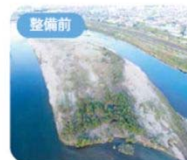
堆砂傾向にあり植生が繁茂していた
