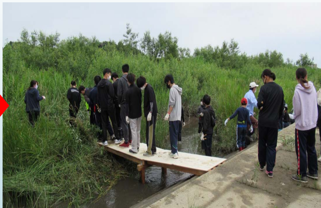
仮橋完成後の様子
