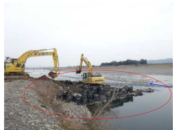
仮設道路撤去状況
