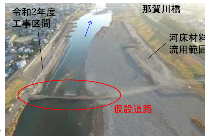
仮設道路設置状況
